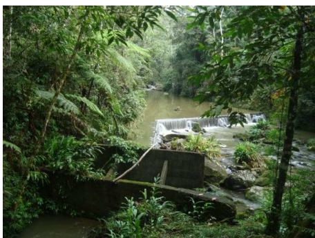
Figura 2.25: Captação de água para truticultura, rio Macaé, localidade de Macaé de Cima, detalhe do vertedor e início do canal (Fonte Consórcio Macaé/Ostras)
