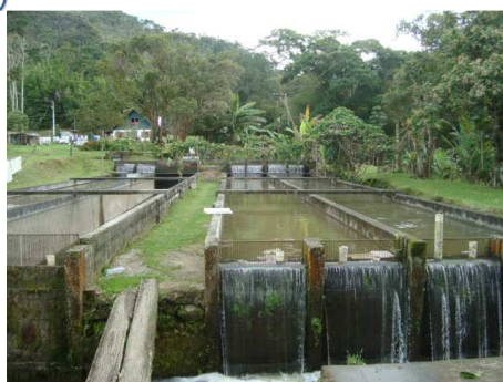
Figura 2.27: Tanques de alvenaria na saída do sistema de criação intensivo de trutas (Fonte Consórcio Macaé/Ostras)
