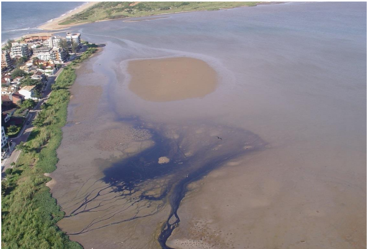
Figura 35. Aporte de esgoto in natura para a Lagoa Imboassica em janeiro de 2008, três dias após uma abertura artificial da barra arenosa da laguna. Fonte: Acervo do Laboratório de Limnologia da Universidade Federal do Rio de Janeiro.
