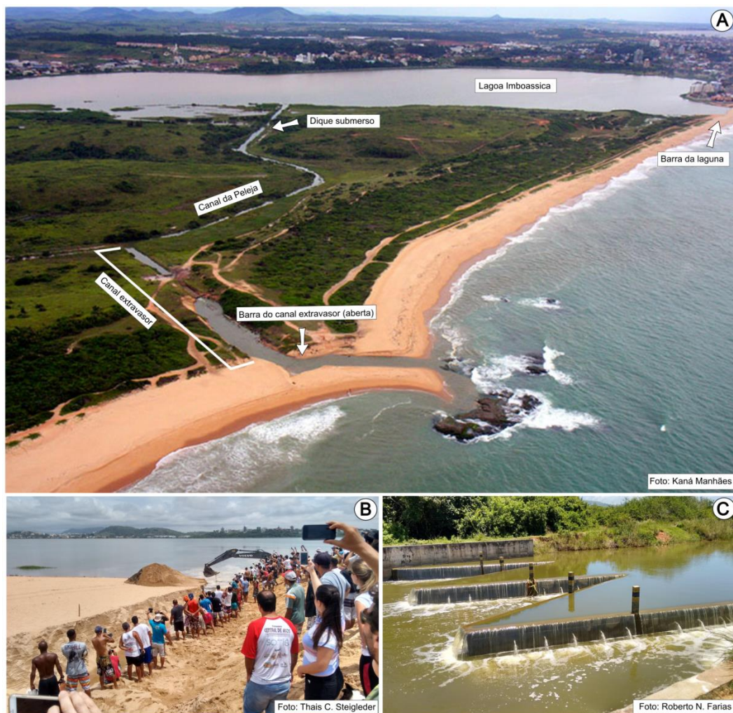
Figura 2. Vista geral da Lagoa Imboassica. A: Possíveis conexões (intermitentes) da laguna com o mar, com destaque para a barra arenosa da laguna, barra arenosa do canal extravasor (após abertura, em junho de 2012), Canal da Peleja, canal extravasor e dique submerso. B: Abertura da barra arenosa da laguna (ao fundo) em novembro de 2016, evento que atraiu a atenção de um grande número de pessoas. C: Dique submerso após a abertura da barra do canal extravasor em dezembro de 2015. O dique impede que a maior parte da água da laguna escoe para o mar (quando a barra do canal extravasor é aberta) e estabelece um nível mínimo necessário para não comprometer a biota aquática e assegurar espaço físico suficiente para receber o aporte de chuva.
