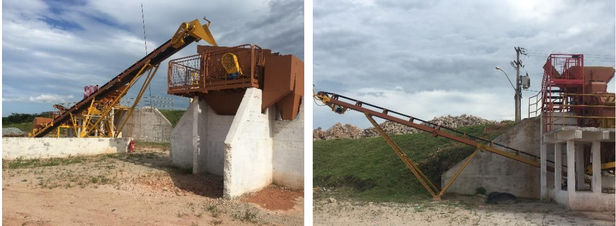
Figura 20 - Equipamentos para reciclagem de RCC no aterro.
