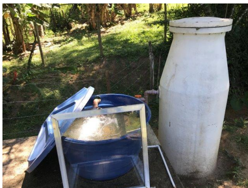
Filtro - Captação Glória
