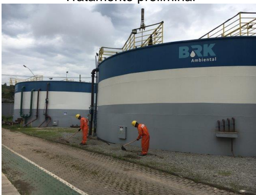
Módulos de tratamento
