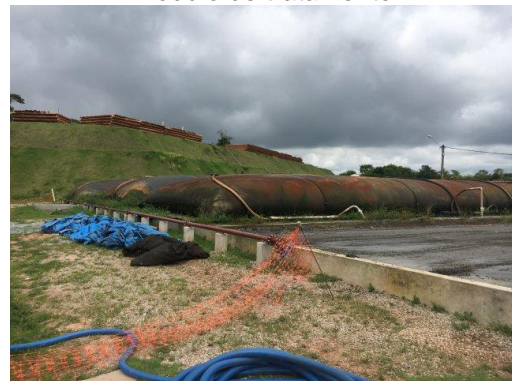
Armazenamento e desidratação do lodo
