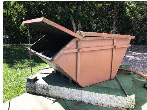
Caçamba para materiais retirados do tratamento primário
