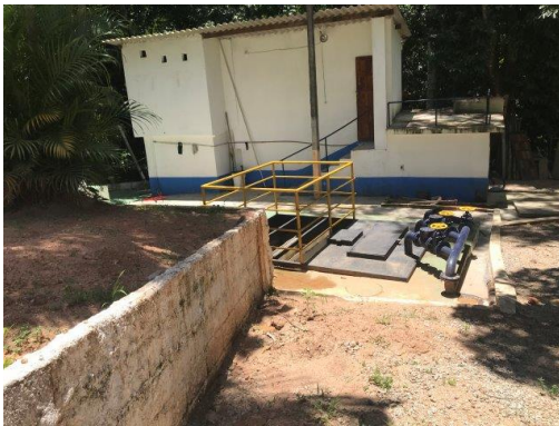
Elevatória de esgoto bruto
