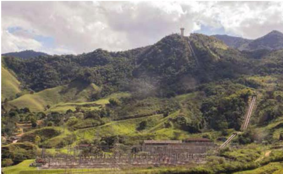
Figura 32 - Transposição do rio Macabu, para o Rio São Pedro. Fonte: Atlas Ambiental da Bacia Hidrográfica do Rio Macaé, 2013.
