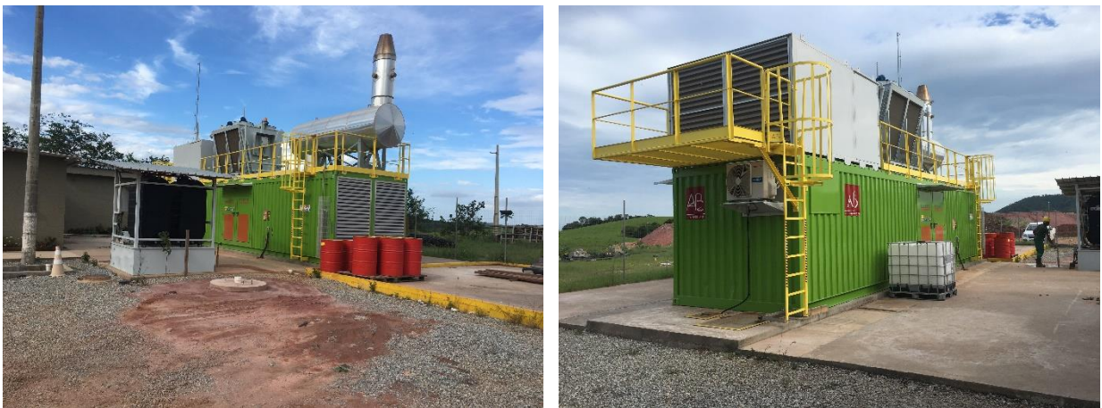
Figura 59 - Unidade de aproveitamento do Biogás - motor de 20 (vinte) cilindros. Fonte: SERENCO.
