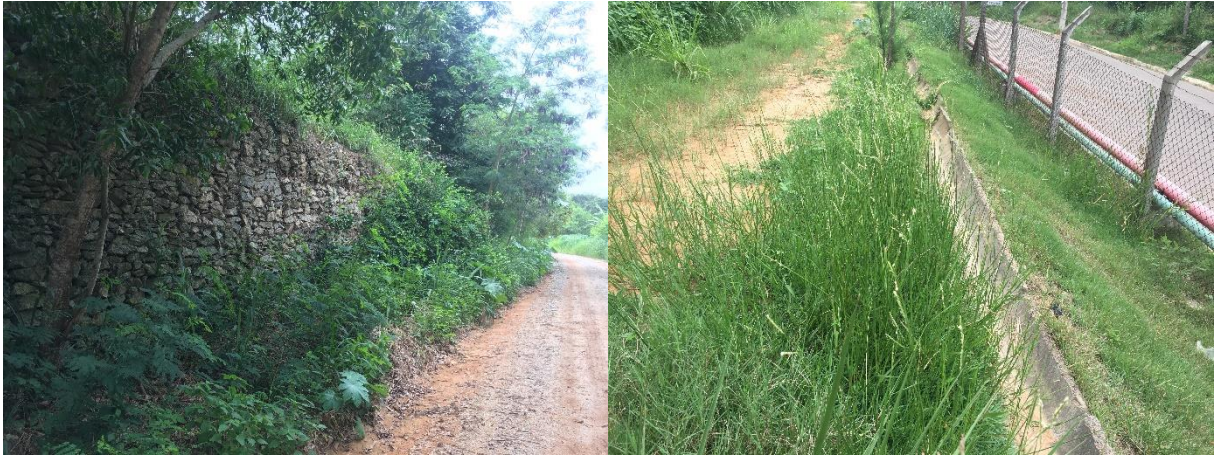
Figura 111 - Contenção de parte do talude com gabião e drenagem pluvial.
