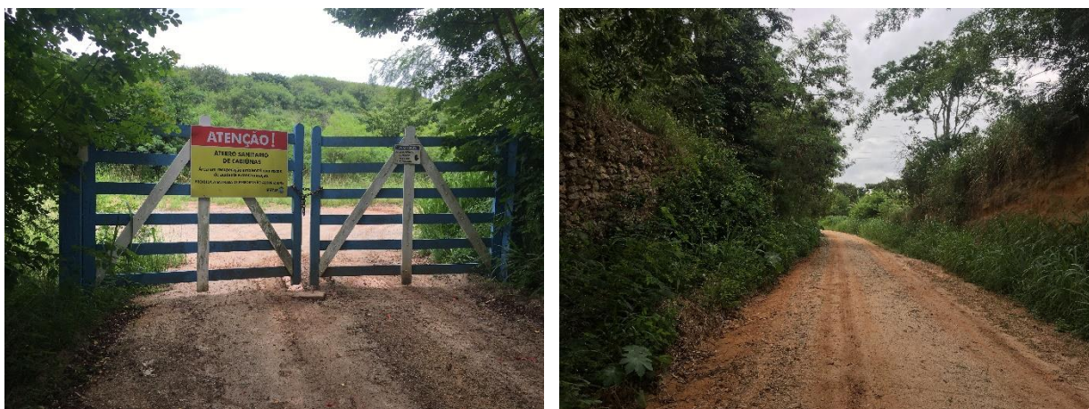
Figura 110 - Entrada do aterro de Cabiúnas. Fonte: SERENCO.
