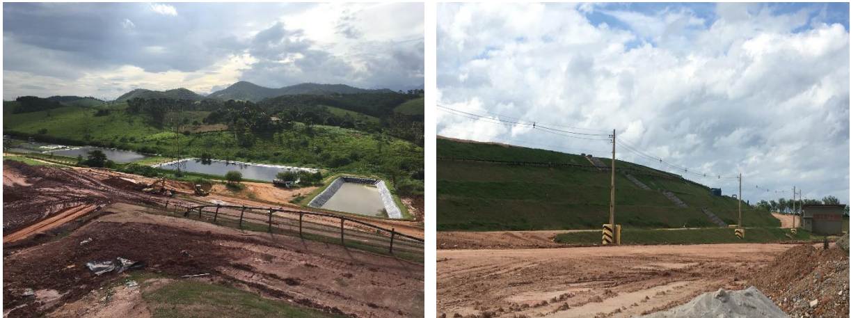
Figura 63 - Vista do topo do maciço de resíduos. Fonte: SERENCO.
