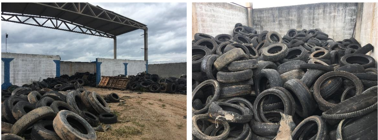
Figura 96 - Galpão para armazenamento temporário de pneu.
