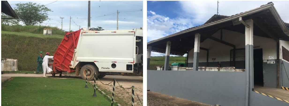
Figura 56 - Área destinada ao tratamento de RSS.
