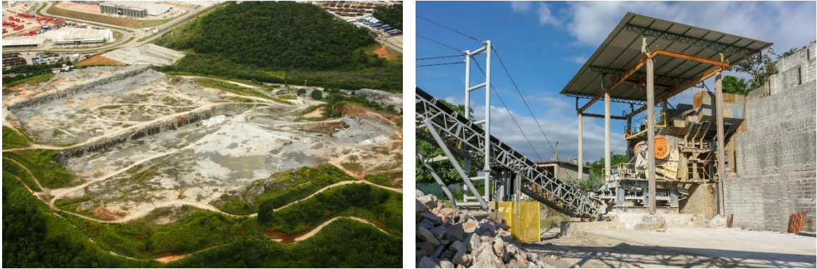
Figura 76 - Área de beneficiamento e britador.
