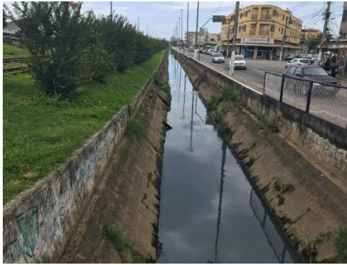
Vista a montante
