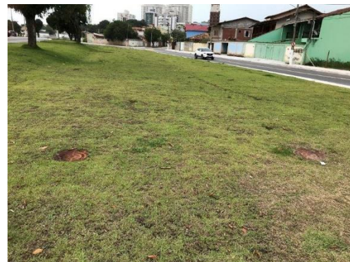
Poços de Visita do canal enterrado
