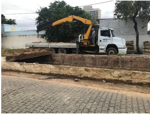
Remoção da laje superior
