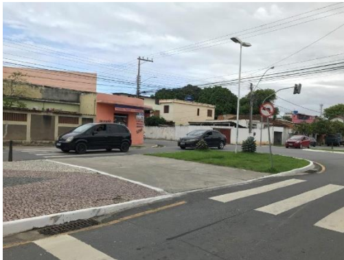
Galeria sob o canteiro central da avenida Prefeito Antônio C. Benjamin
