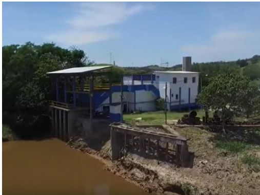
Captação de Água Bruta
