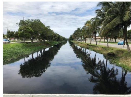
Ponte na frente da ETE Infraero
