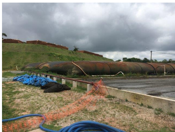
Figura 75 - Armazenamento e desidratação ETE Centro e caçamba para armazenamento de materiais retirados no tratamento primário da ETE Sana.
