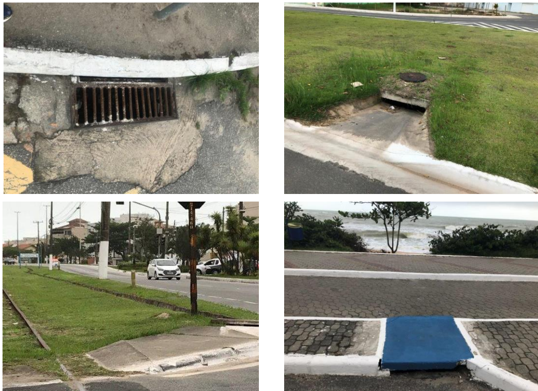
Figura 22 - Diferentes tipologias de bocas de lobo/leão, bueiros e sarjetas do município de Macaé.
