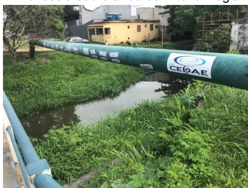
Vista a jusante (RJ-168)
