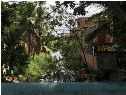
Vista a jusante (da RJ-168, canal paralelo a rua Perjentino Gomes)
