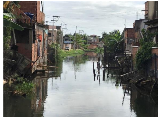
Canal sob a rua Antônio Bachara Filho (próximo da união com o canal do Capote)
