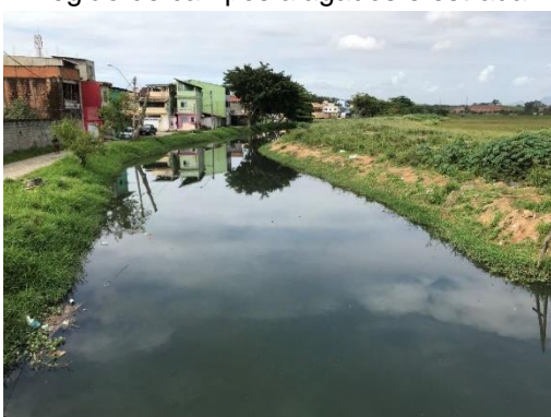
Vista a montante (RJ-168)
