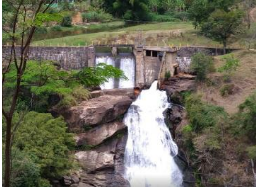
Barragem de Glicério
