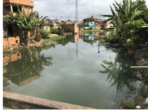
Vista a jusante (rua Antônio Bechara Filho)
