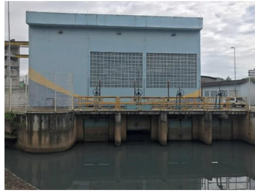
Entrada da elevatória
