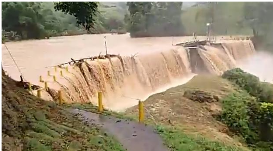
Barragem do Frade, 2018.
