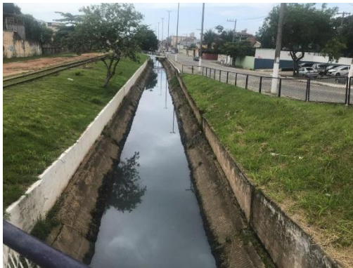
Vista a montante
