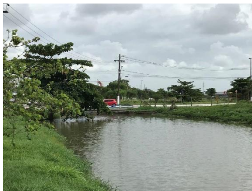
Travessia sobre a rua da Vitória Régia
