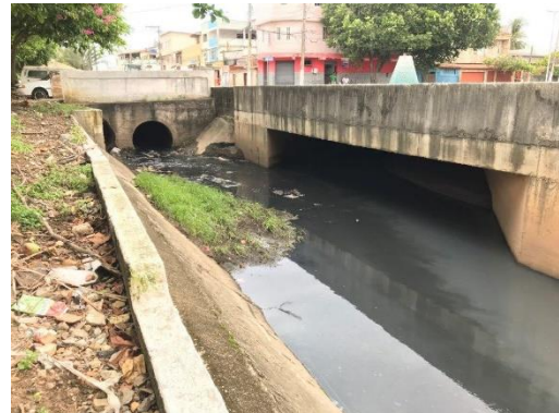
Galerias fechadas desembocando no Canal Fábio Franco
