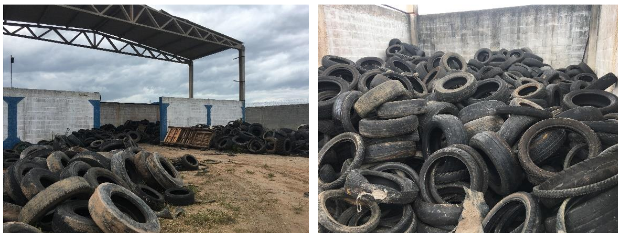
Figura 81 - Galpão para armazenamento temporário de pneu.
