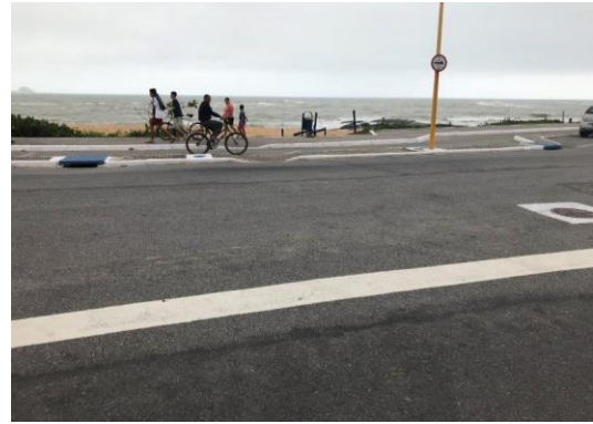
Via asfaltada com sarjeta e bueiro
