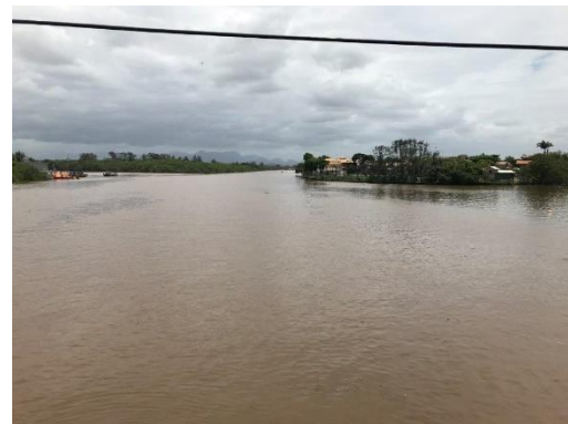
Ponte na RJ-106
