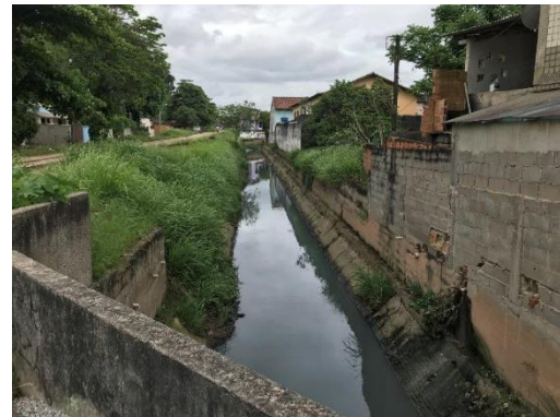
Vista a jusante
