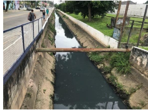
Vista a jusante
