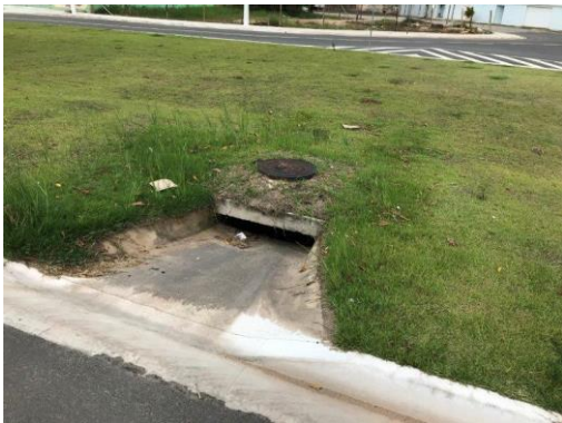
Entrada da água no bueiro do canal enterrado
