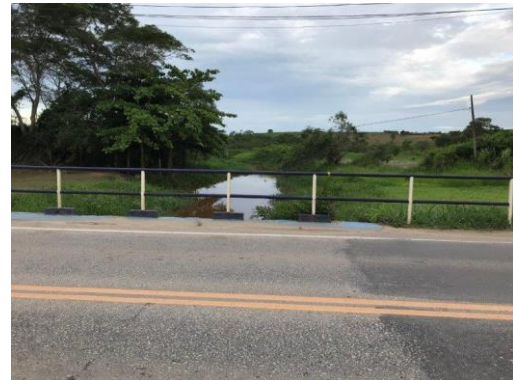
Vista a jusante da RJ-106 (Rod. Amaral Peixoto)
