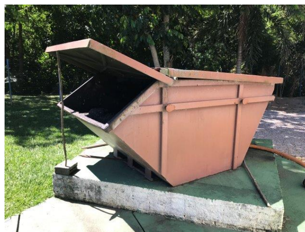
Figura 75 - Armazenamento e desidratação ETE Centro e caçamba para armazenamento de materiais retirados no tratamento primário da ETE Sana.
