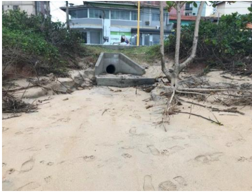
Estrutura de desemboque para minimizar a erosão
