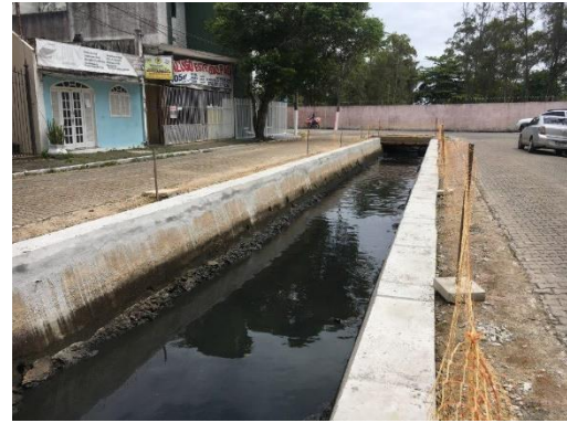
Canal próximo ao muro do exército
