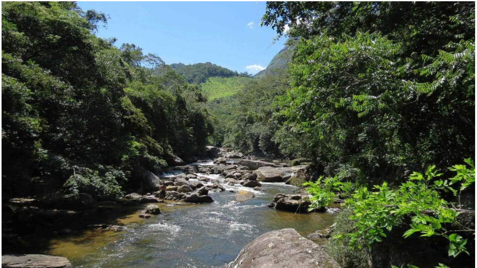
Projeto prevê a construção de barragem no leito do Rio Macaé
