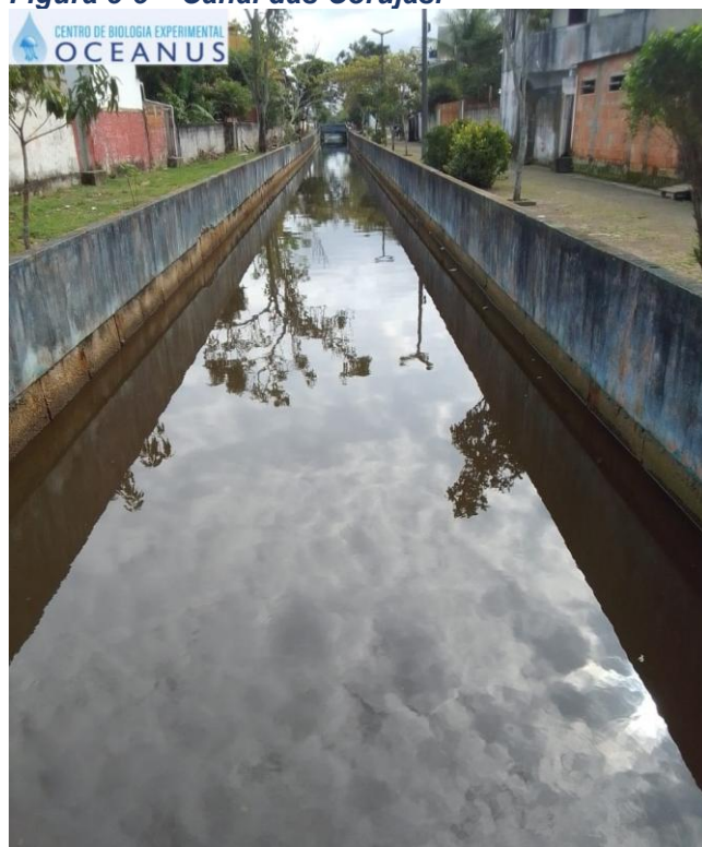
Figura 3-5 – Canal das Corujas.
