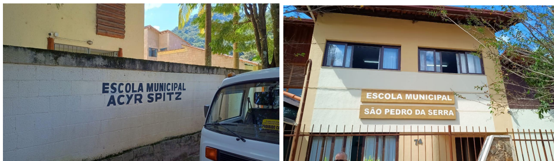
Figura 10 e 11 - Registros fotográficos da Escola Municipal Acyr Spitz e da Escola Municipal São Pedro da Serra
