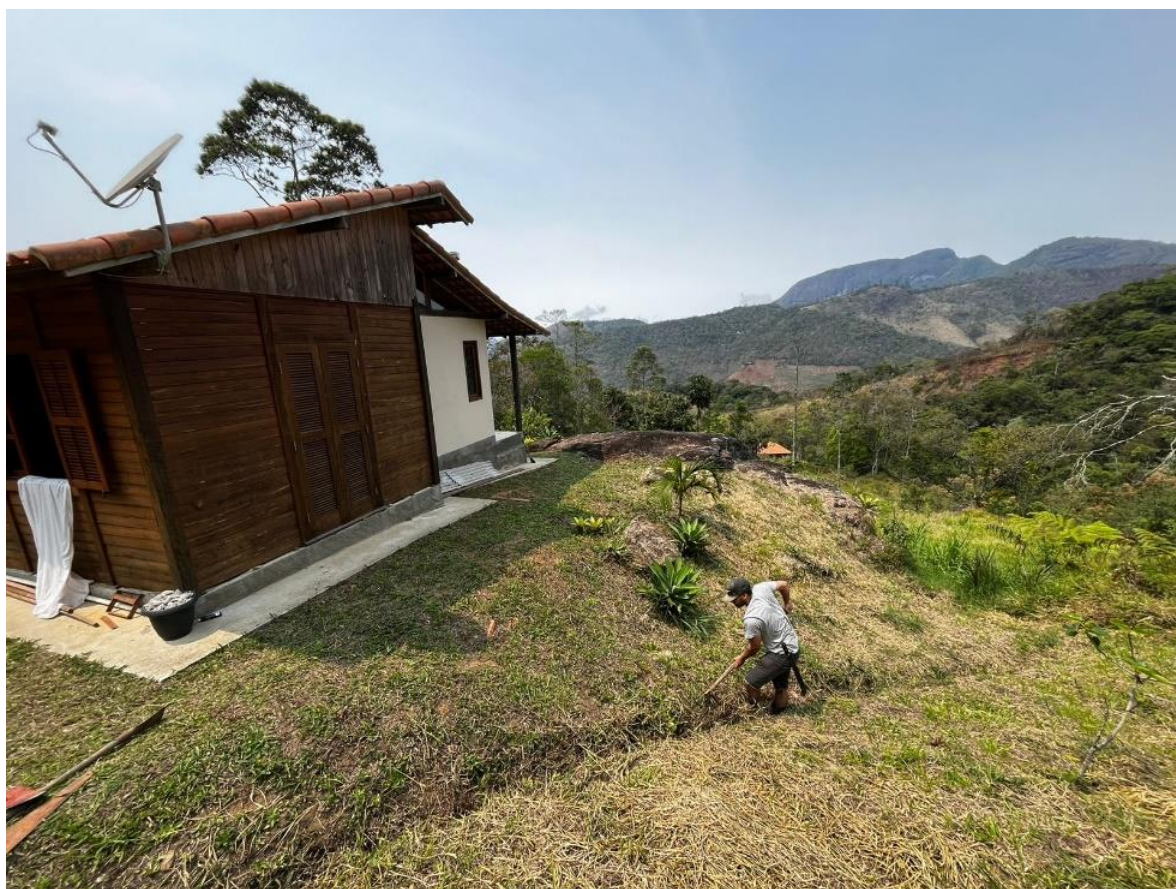
Figura 11 - Residência e valeta ao lado Fonte: Aplicar Engenharia, 2024.
