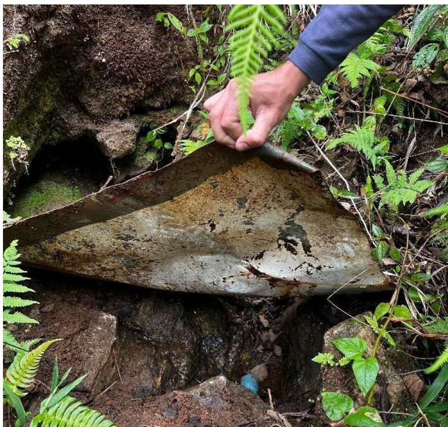
Figura 2 - Captação de água, realizada de forma rústica. Fonte: Aplicar Engenharia, 2024.
