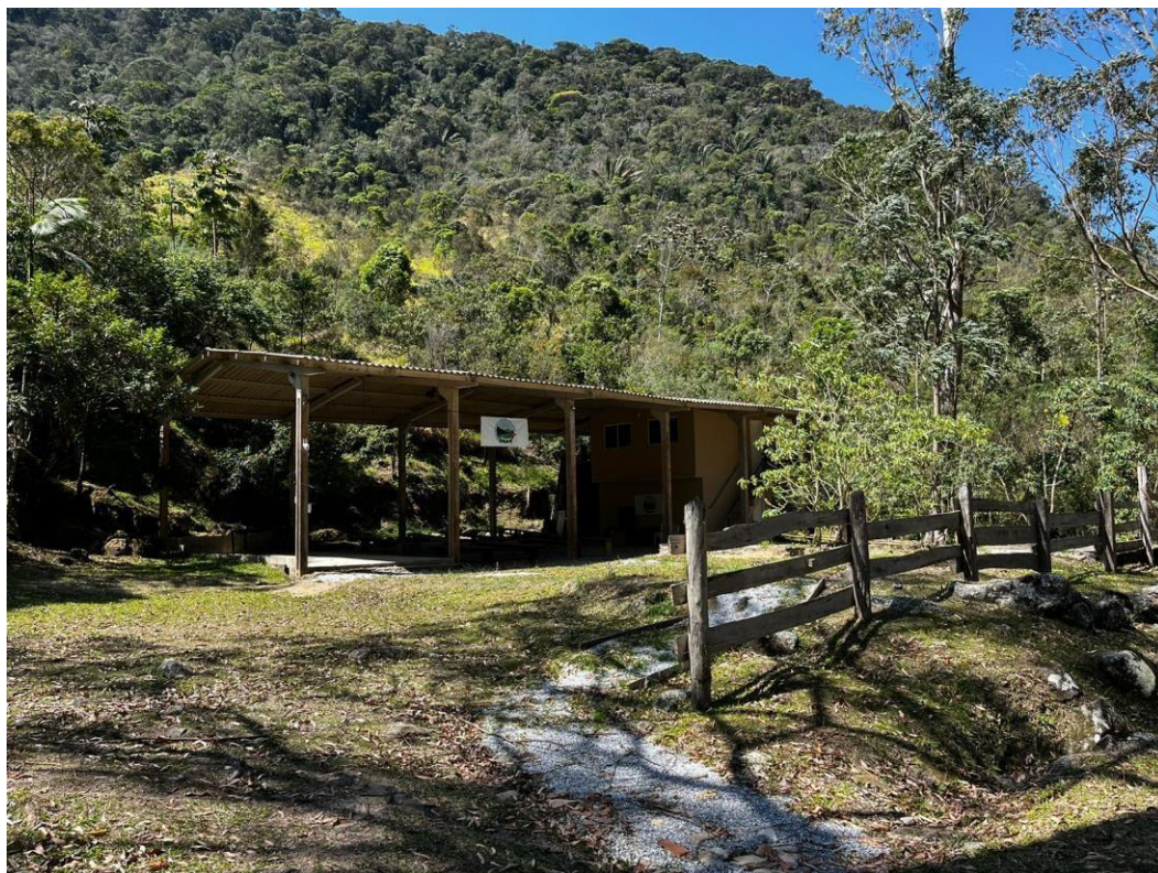
Figura 10 - Galpão construído e destinado para visitas. Fonte: Aplicar Engenharia, 2024.
