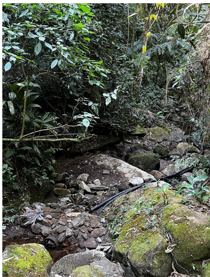
Figura 3 - Captação de água feita na propriedade para abastecimento público alternativo.
