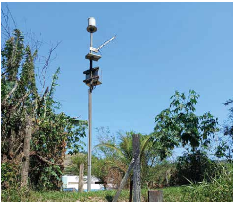
FIGURA 8 – ESTAÇÃO DE MONITORAMENTO.
