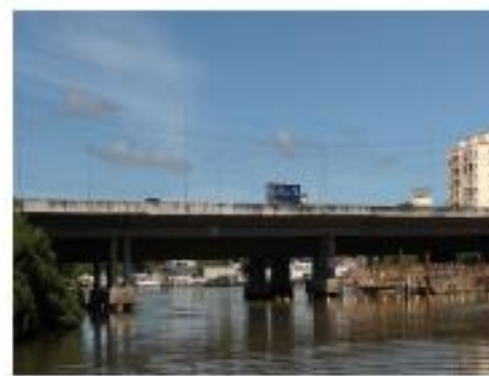
22 - Ponte da BR 101
